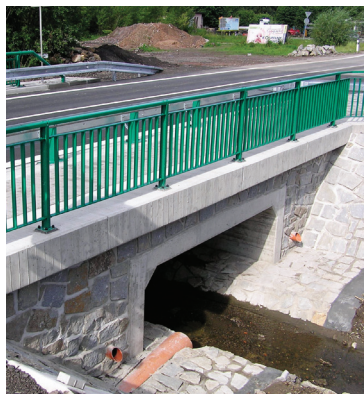
Zrekonstruovaný most v Jičíně.
